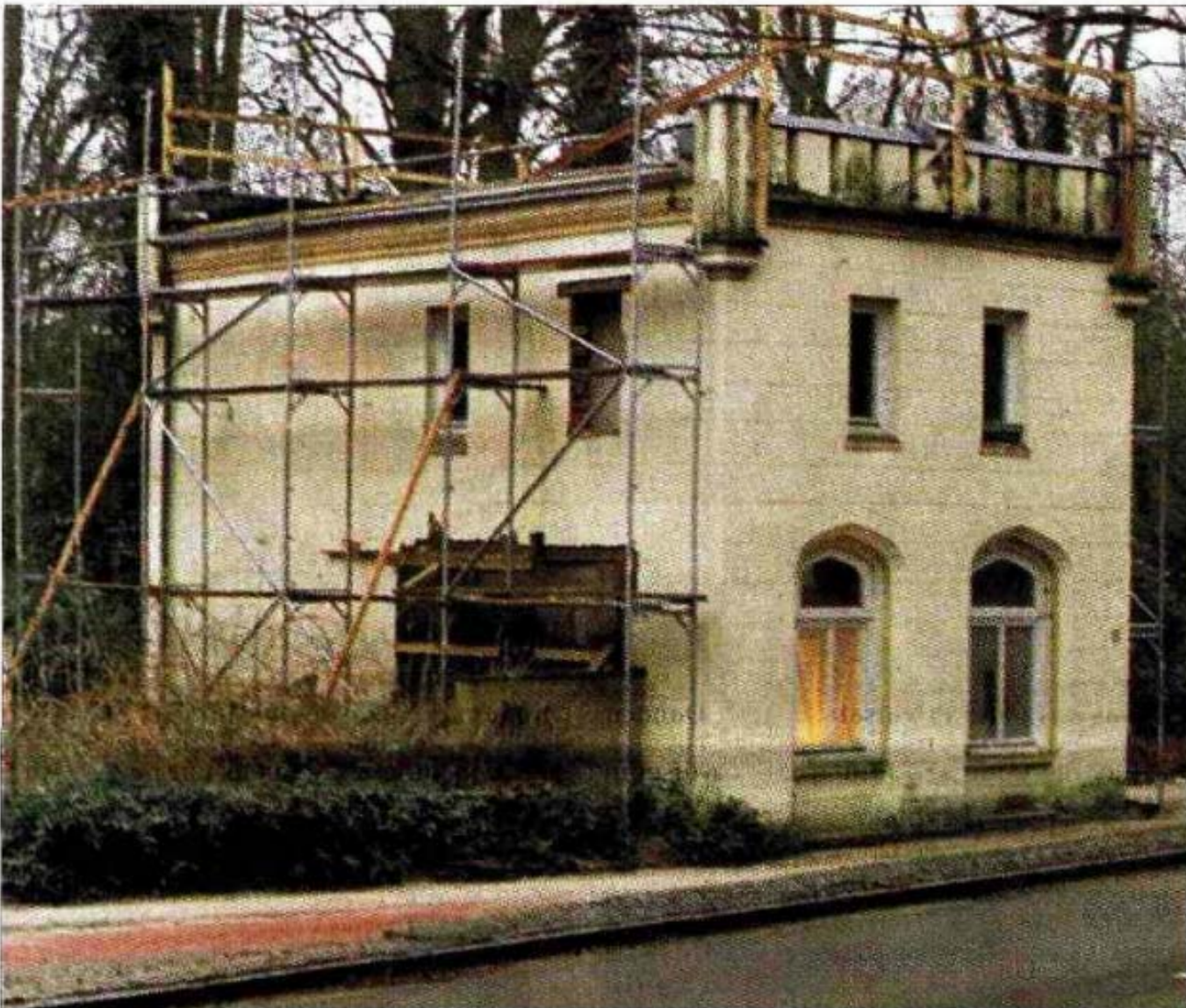
In das Torhaus im Eingangsbereich zu Knoops Park, das derzeit saniert wird, soll ein Parkwächter einziehen. Die Stiftung wird das Gebäude nach den Bauarbeiten übernehmen. Foto: Kono
