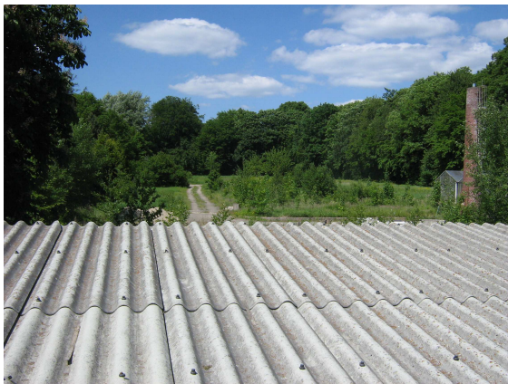
Blickrichtung: von Süden nach Norden
