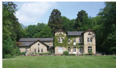
Historischer Gebäudebestand Haus Blumenkamp
