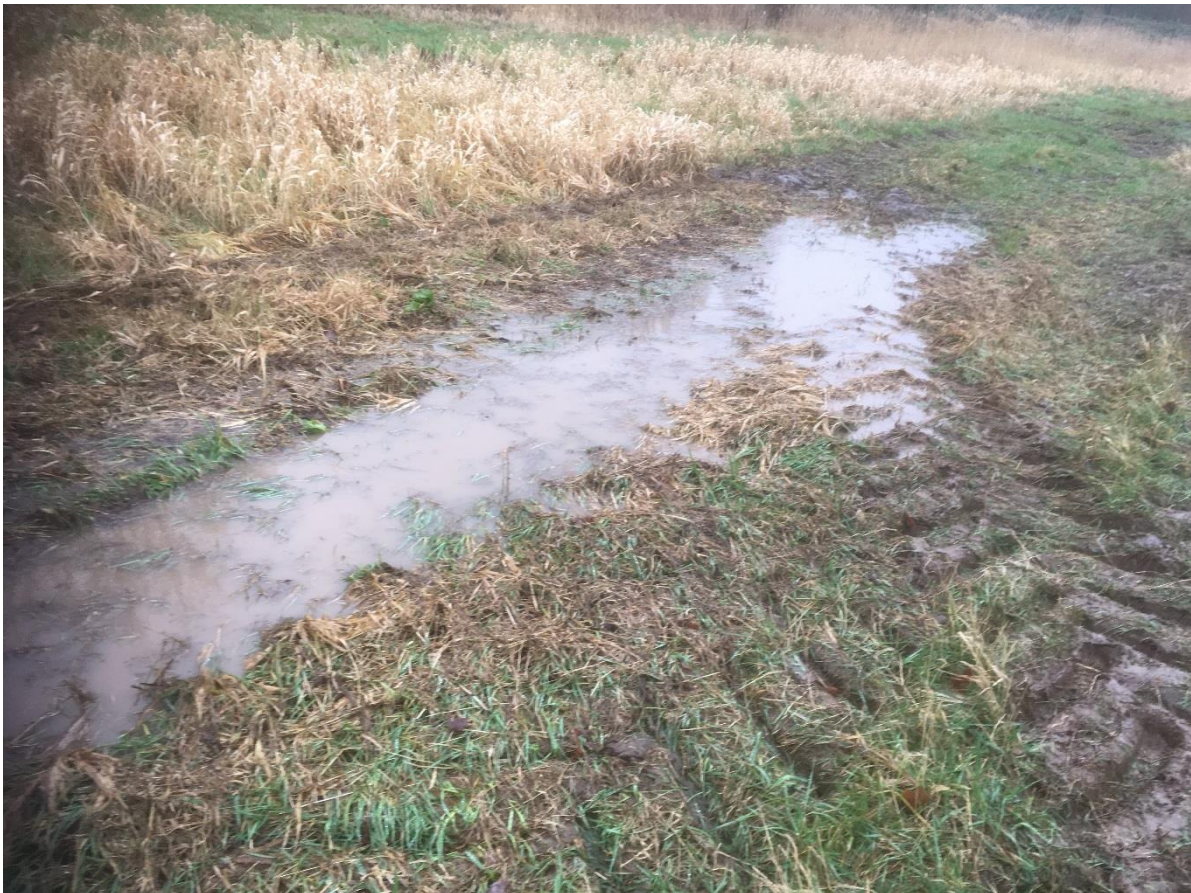
Baubeginn am 3.2.2020 (Foto 4, Bienle)
