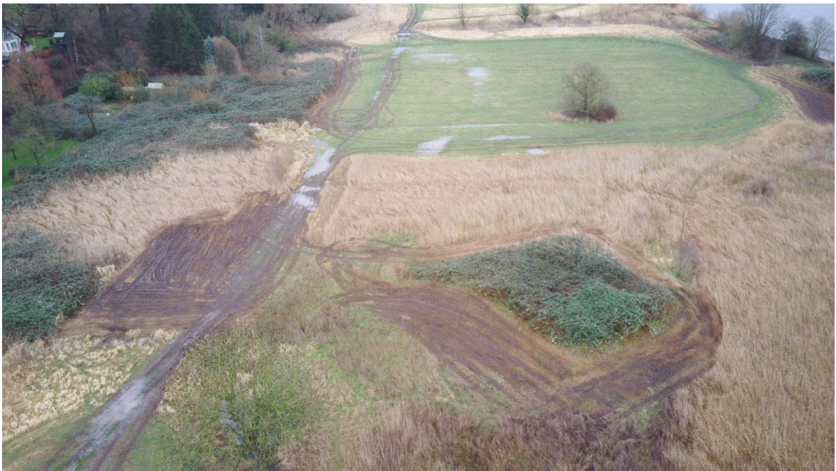
Baubeginn am 3.2.2020 (Foto 7, Bienle)
