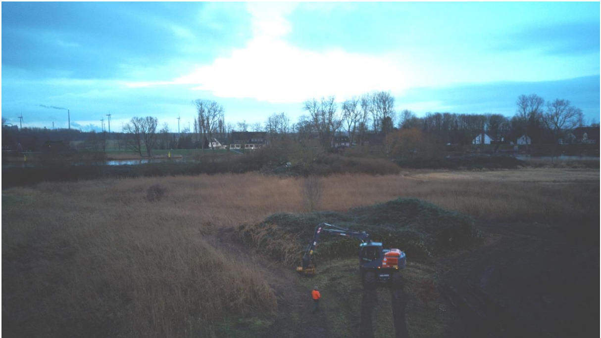
Baubeginn am 3.2.2020 (Foto 8, Bienle)
