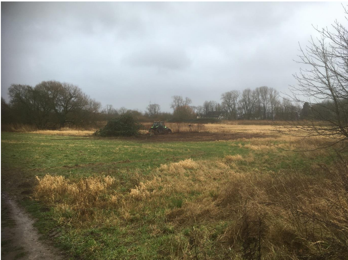
Baubeginn Flachwasserzone in den Lesumwiesen am 3.2.2020 (Foto 1, Bienle)
