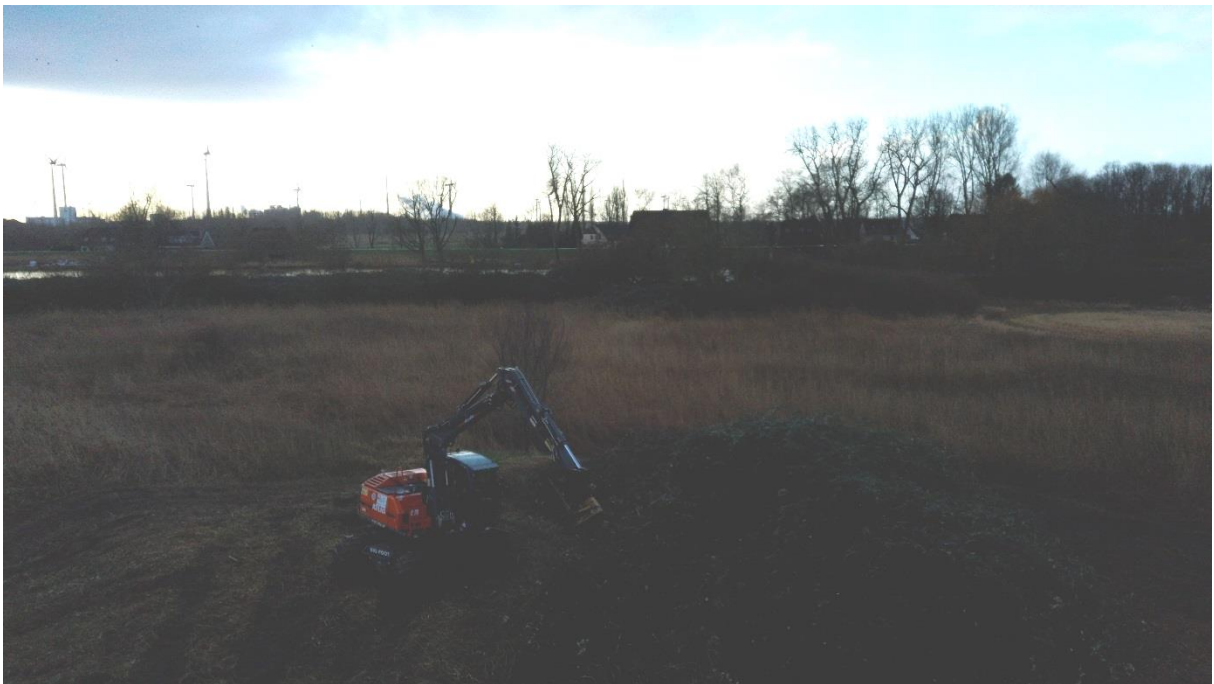
Baubeginn am 3.2.2020 (Foto 9, Bienle)
