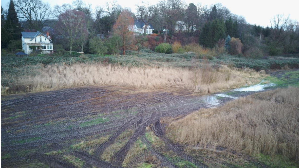
Baubeginn am 3.2.2020 (Foto 10, Bienle)
