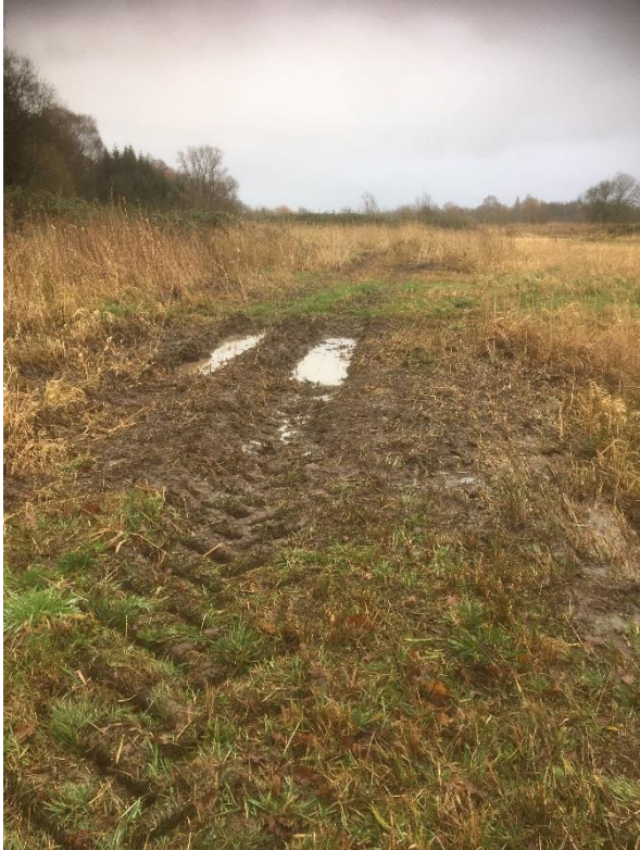
Baubeginn am 3.2.2020 (Foto 2, Bienle)
